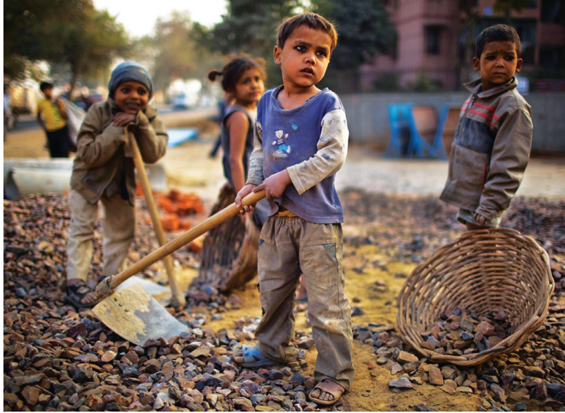
△ 童工在建筑工地工作
